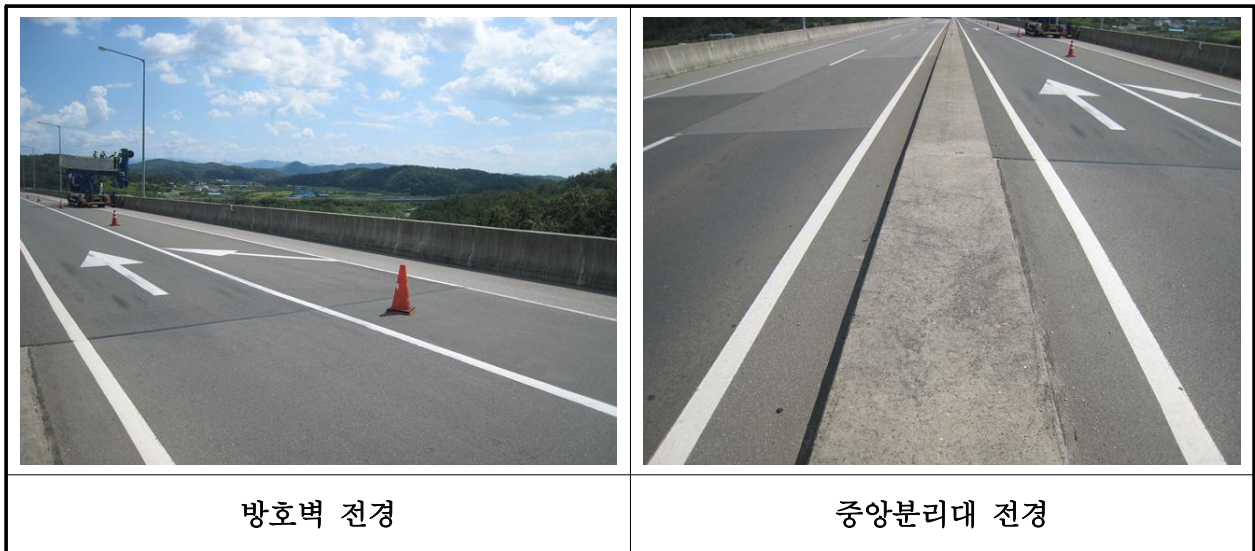
【사진 29.3.23】 방호벽 및 중앙분리대 전경
