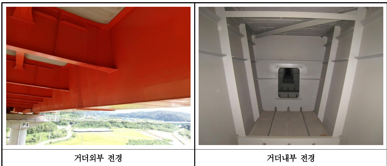
【사진 29.3.4】 거더 전경
