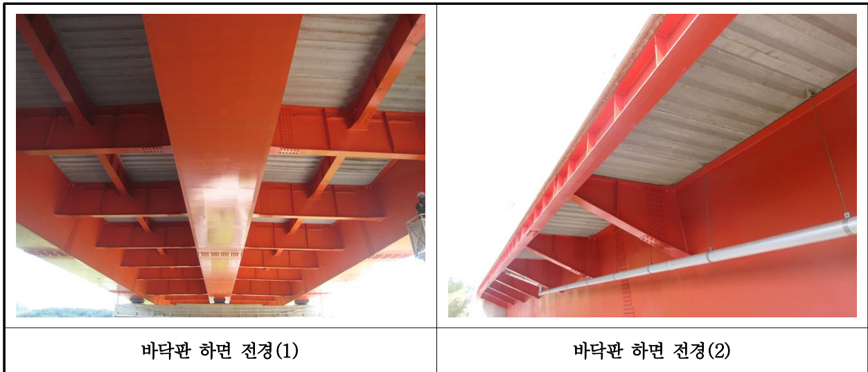
【사진 29.3.2】 바닥판하면 전경
