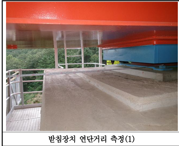
【사진 29.3.14】교량받침장치 연단거리측정
