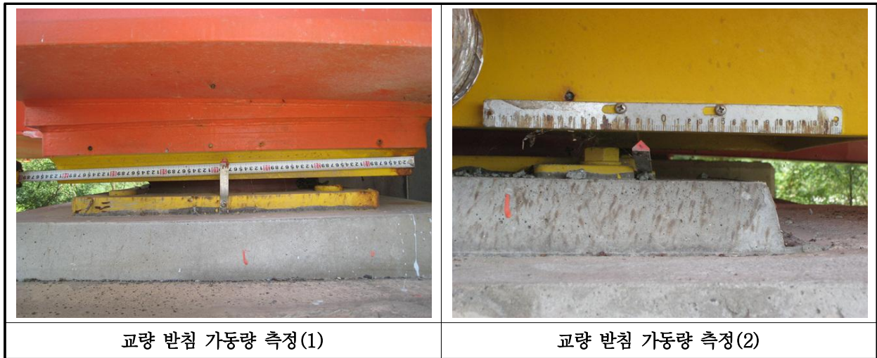
【사진 29.3.15】 교량받침 이동량 측정
