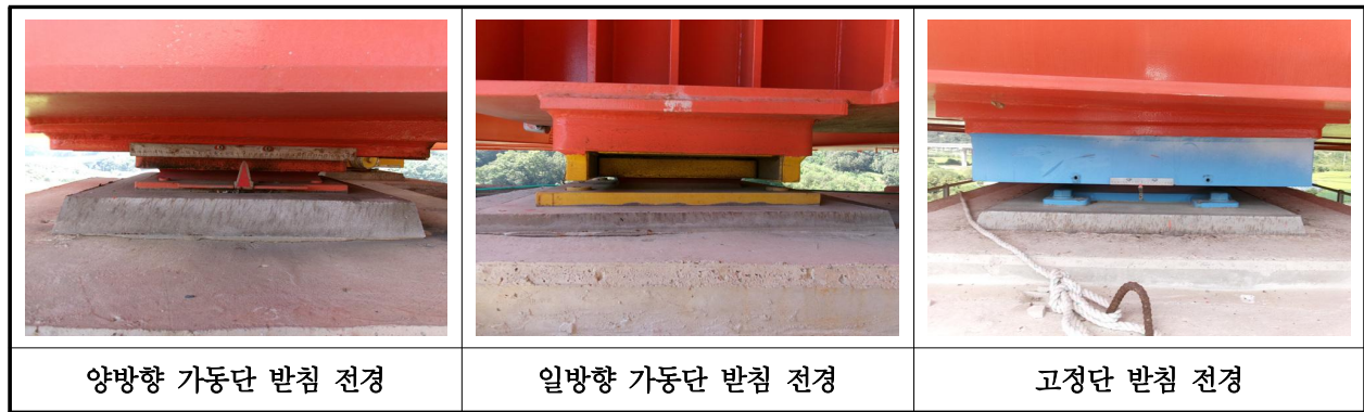
【사진 29.3.12】 교량받침 전경
