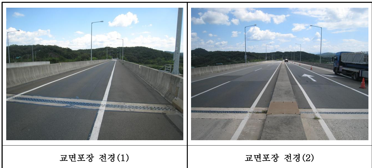
【사진 29.3.19】 교면포장 전경
