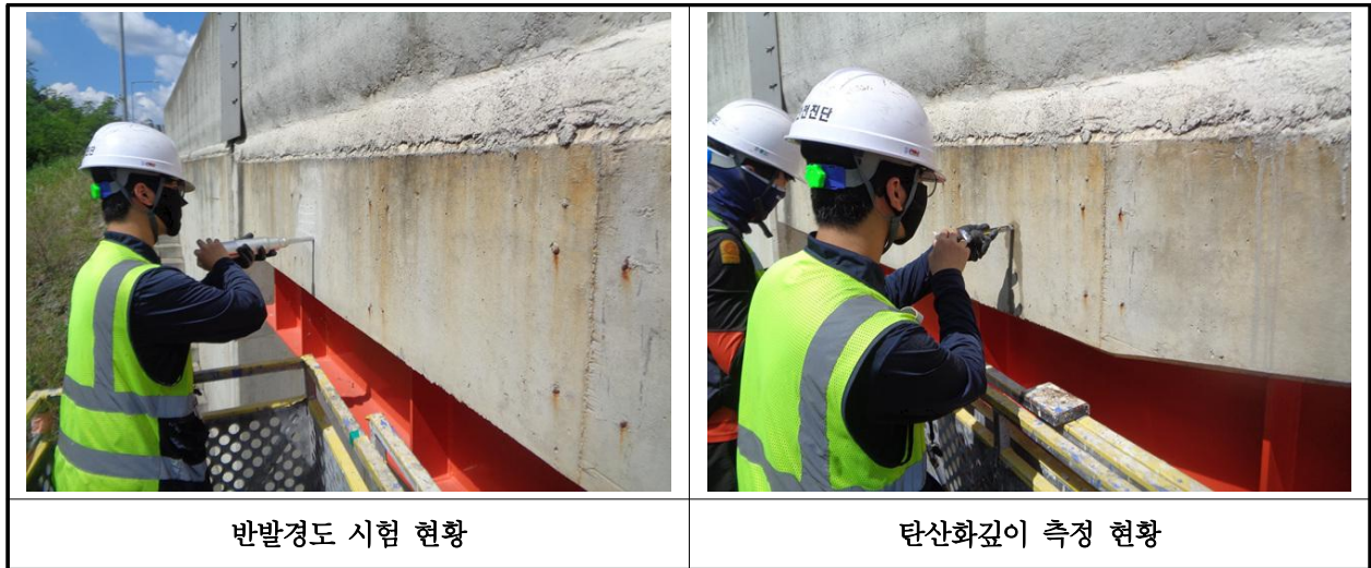
【사진 29.4.1】 콘크리트 내구성조사 현황
